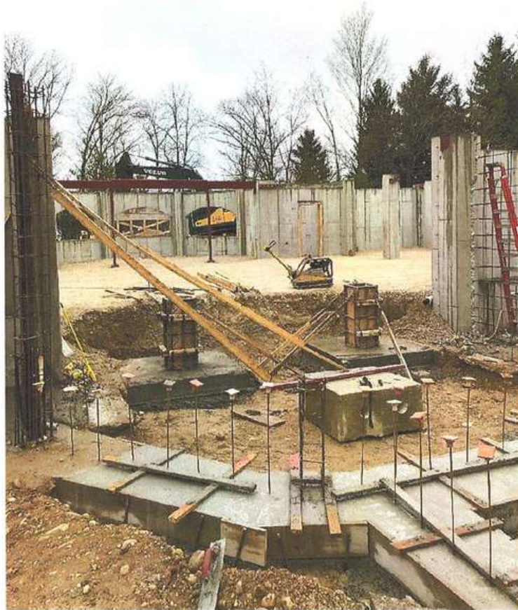
Zdj. 3 Fundamenty Kaplicy – zachodnia strona
