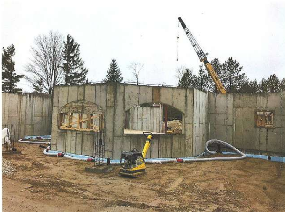
Zdj. 4 Fundamenty Kaplicy – wschodnia strona
